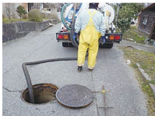
バキューム車での汚水吸い上げ(二次調査)
