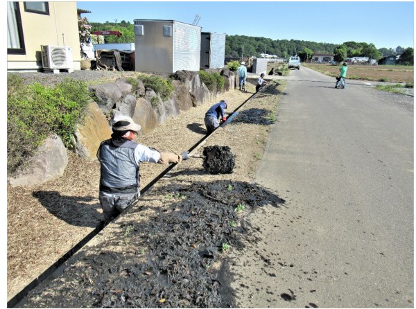
水路の泥上げ
