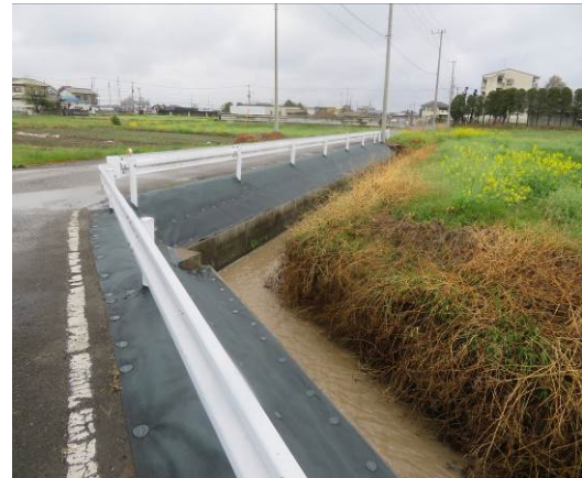
防草シート敷設状況
