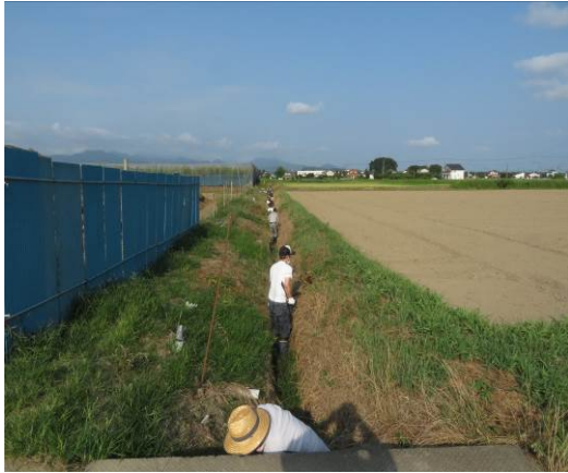
排水路の泥上げ作業
