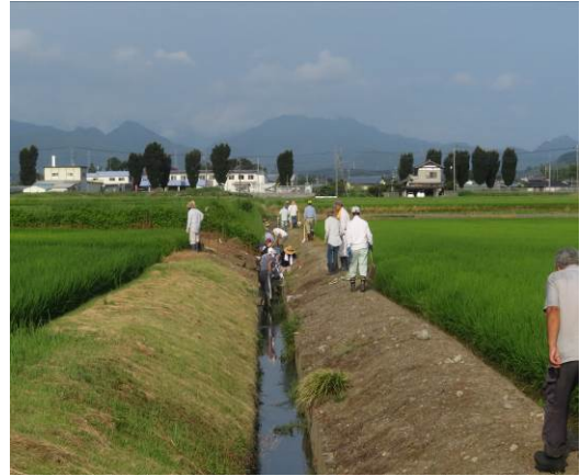
排水路の泥上げ作業
