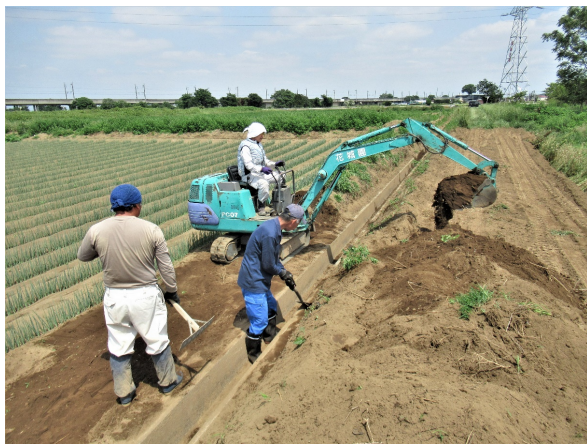
水路の残土処理作業
