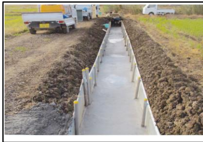
( 水路補修工事 )
