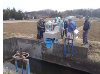
（ 施設の機能診断の研修 ）
