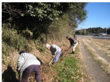
（ 水路の泥上げ ）
