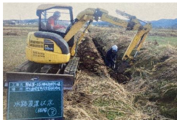
排水路の浚渫
