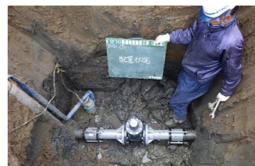
パイプライン 制水弁、空気弁の更新
