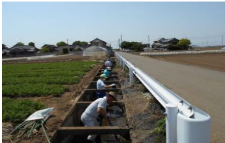
( 水路の泥上げ )
