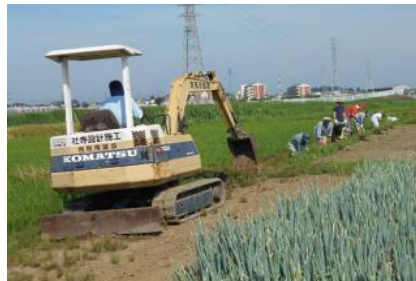
( 水路の泥上げ )
