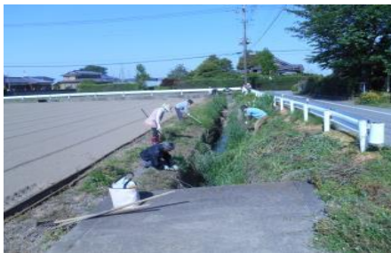
( 水路の泥上げ )
