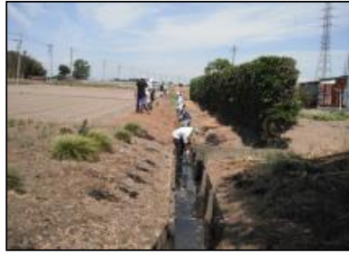
( 水路の泥上げ )
