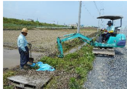
( 水路の泥上げ )
