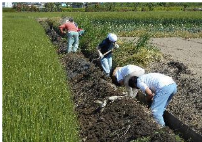
( 水路の泥上げ )
