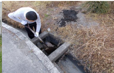
用水路の泥上げ
