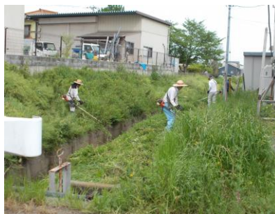
排水路の草刈り
