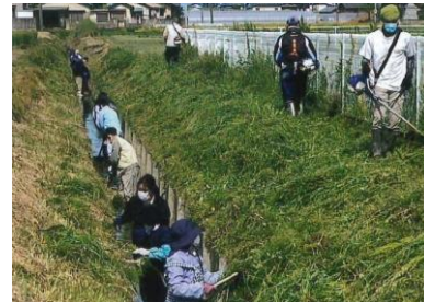
水路の泥上げ作業
