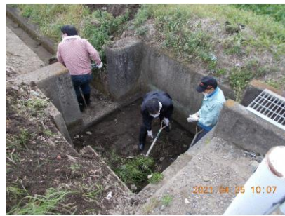
排水路の泥上げ
