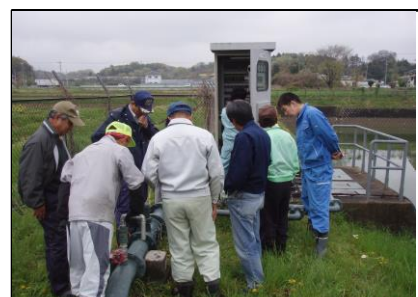
(揚水機の維持管理状況)
