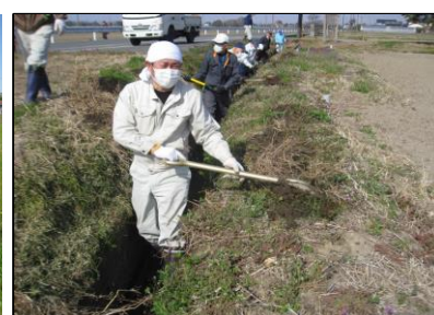
( 水路の泥上げ )
