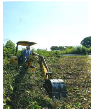
重機を使用した草刈り
