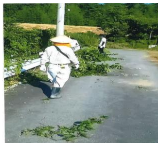
排水路の草刈り
