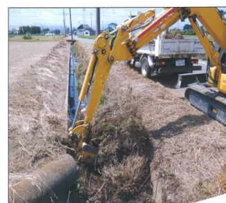
重機による排水路の浚渫
