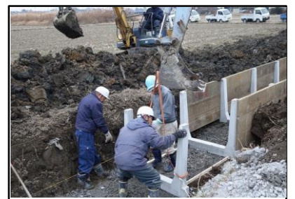
( 水路更新作業 )
