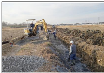
( 水路更新作業 )
