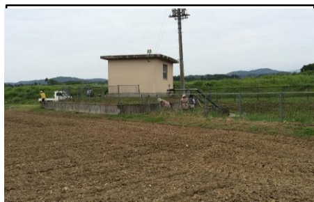
(ポンプ小屋周辺の草刈り)
