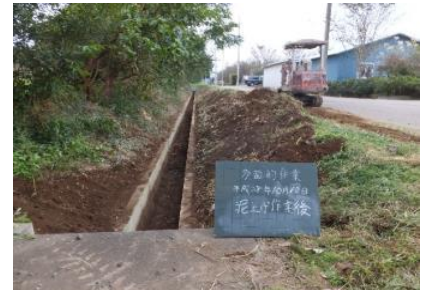
( 水路の泥上げ )
