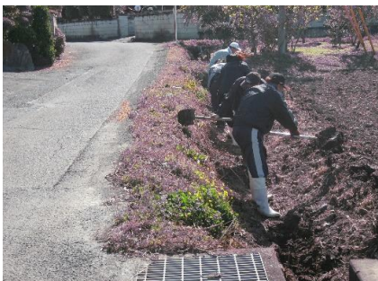
(用水路の泥上げ)
