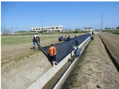
(防草シート張り)
