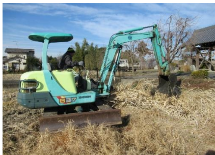
(用水路の泥上げ)
