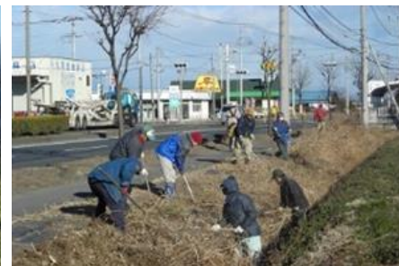
(水路の草刈り、泥上げ)
