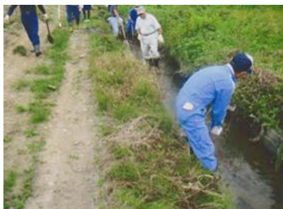
(水路の泥上げ)
