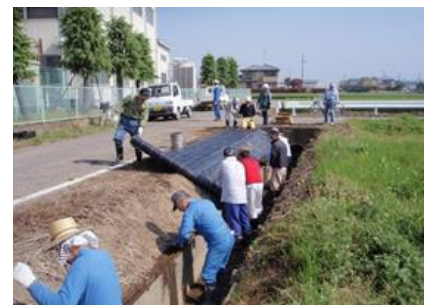
(防草シートの設置)
