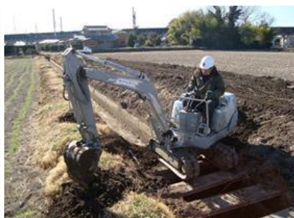
(開、排水路土砂除去)
