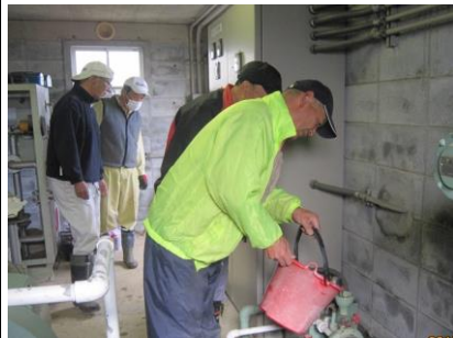
(ポンプ小屋の点検)
