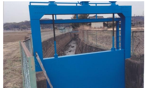
(堰のペイント塗装)
