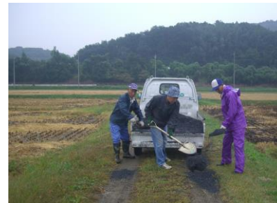
(農道の補修作業)
