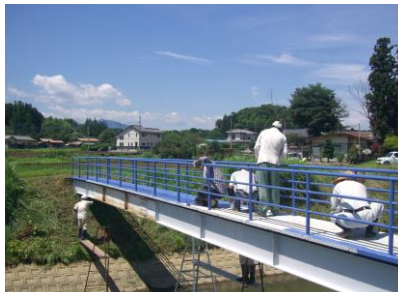
(送水管(橋梁)の塗装作業)
