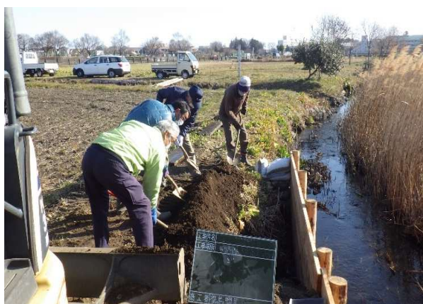
水路補修（長寿命化）
