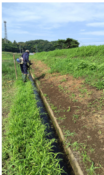
用水路の泥上げ
