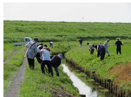
( 水路の除草作業 )
