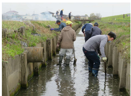
( 水路の堀さらい )
