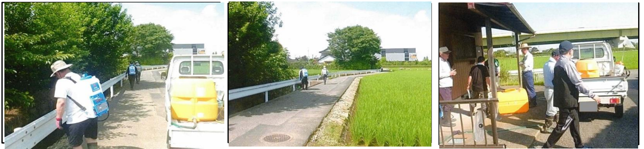
( 除草剤散布作業の様子 )
