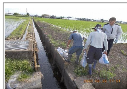
（軽微な補修作業）
