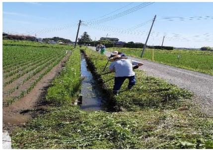
(排水路草刈り作業)
