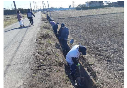
(排水路泥上げ作業)
