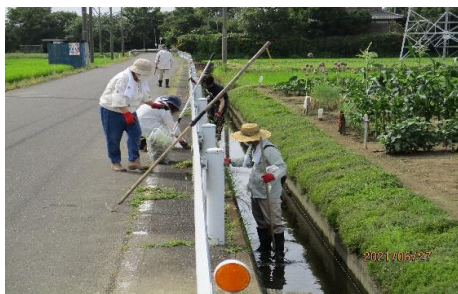
(コンクリート水路の泥上げ 川端南)
