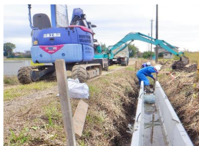
( 水路更新工事 )
