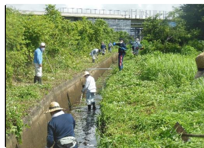
(水路浚い作業)
