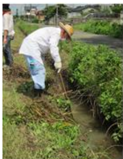
( 泥上げの様子 )
