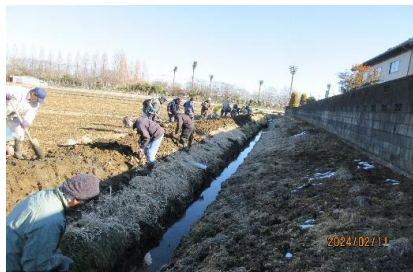
(水路の掘り浚い)
