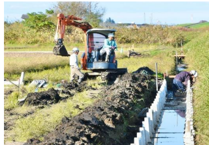
( コンクリート水路への更新 )
