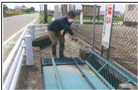
(施設の点検作業)
