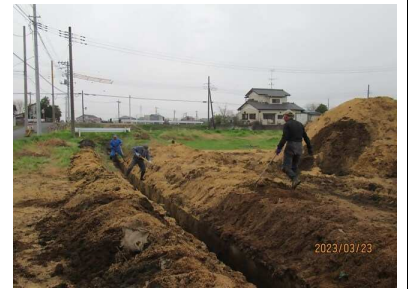
(水路の泥上げ)
