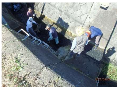
( 開水路の泥上げ )
