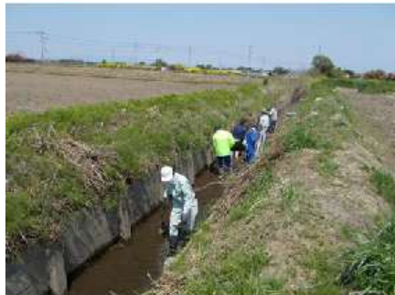
( 用水路の泥上げ )
