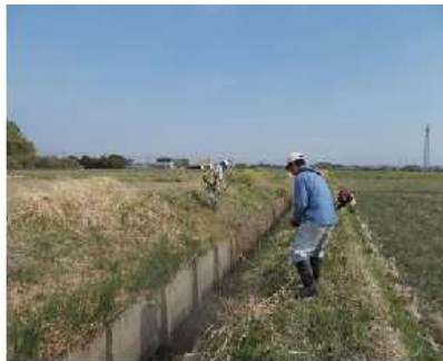
( 排水路の草刈り )
