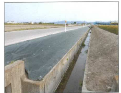
(防草シート敷設状況)
