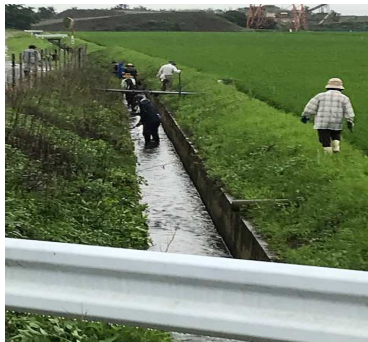
(排水路の草刈り)
