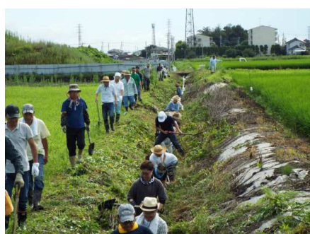
( 排水路の泥上げ )
