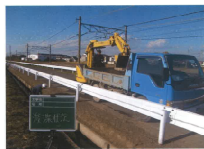
(重機による排水路の浚渫)
