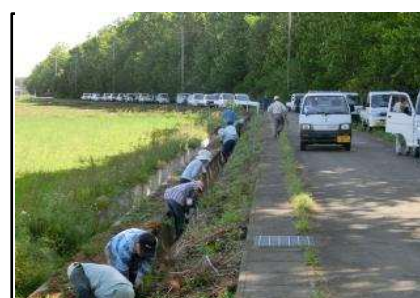
( 水路の泥上げ )
