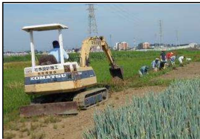
( 水路の泥上げ )
