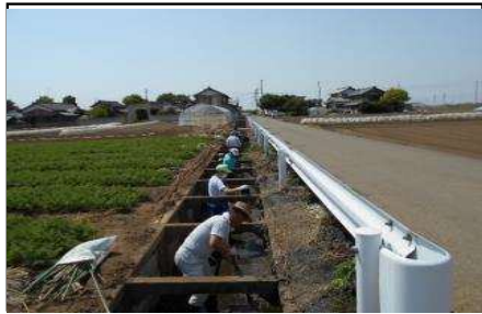
( 水路の泥上げ )
